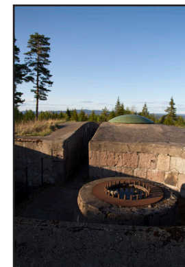
Vardefortet er et populært turmål. Mye av anlegget er tilgjengelig for publikum, inkludert kanonstillingene på toppen.
