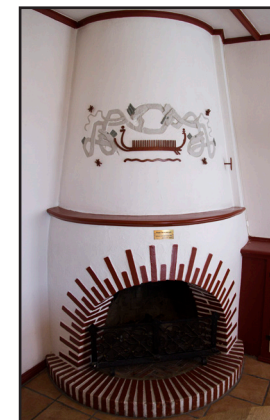
Denne peisen ble oppmurt av Grini-fange Olaus Aanesland fra Birkenes og montert av HV-04 i 1993.
